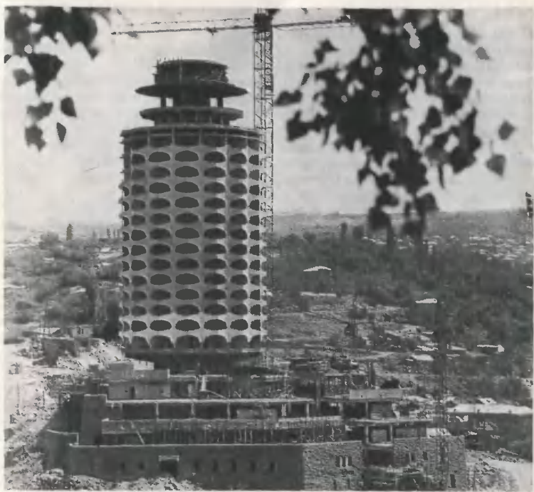
Строится Дом студента в Ереване. Архитекторы решили сделать его круглым в плане.
